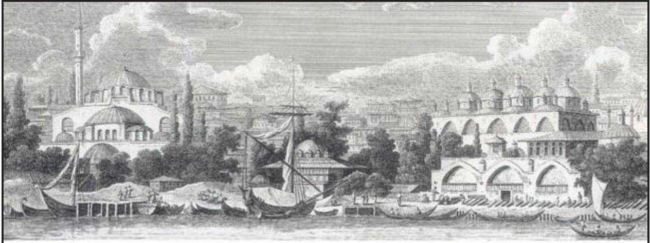
Tophane Dökümbhanesi ve Meydanı The Tophane Foundry and Square
